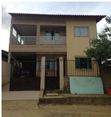
Figura 4. Fachada frontal da Unidade Residencial denominada Amostra 2
